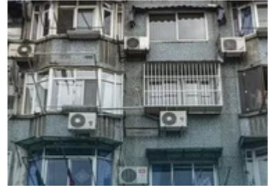
Le pompe di calore in oggetto sono sottoposte nella condizione di messa al regime funzionale, a cicli di on/off (pendolamenti) che compromettano la vita del compressore a scapito dell'efficienza dell'impianto, mandando in blocco l'apparecchiatura, per far fronte agli sbrinamenti dovuto allo scarso contenuto di acqua nella distribuzione a split o fan-coil.
