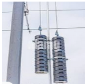
I contrappesi per messa in tensione della linea elettrica
