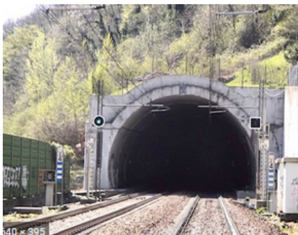
La galleria di Lecco in prossimità della stazione
