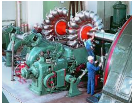
Montaggio turbine idroelettriche
