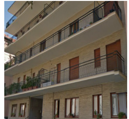
fac simile dello strutturale dell'edificio in oggetto
