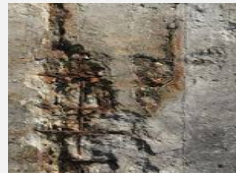
ESPLOSIONE DEL FERRO FORMAZIONE SPALLING
