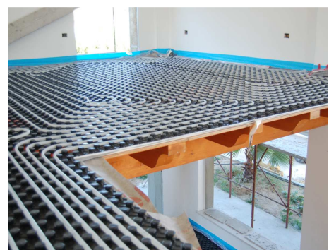
Struttura di posa del soppalco
