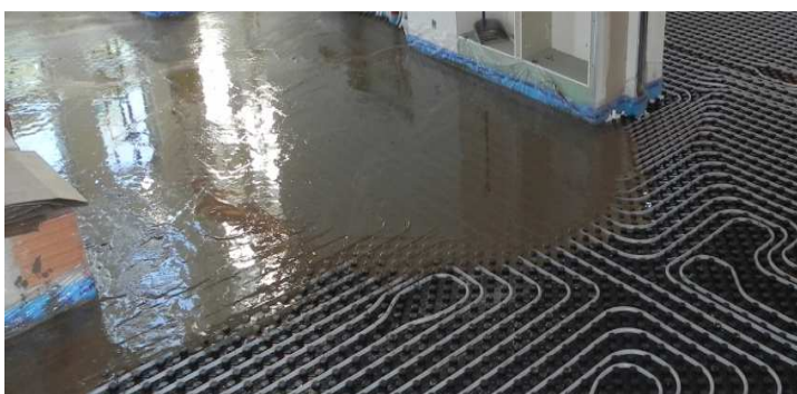
Struttura di posa ambiente abitativo con getto autolivellante conglomerato cementizio
